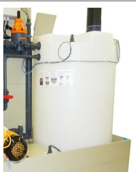
**Abbildung 10, Integrierter Puffertank, Ansicht von hinten**
